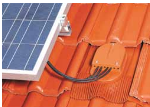
Systémové riešenie prestupu elektroinštalácie
