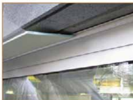
5. Zasunutí systémové desky do připojovacího profilu
