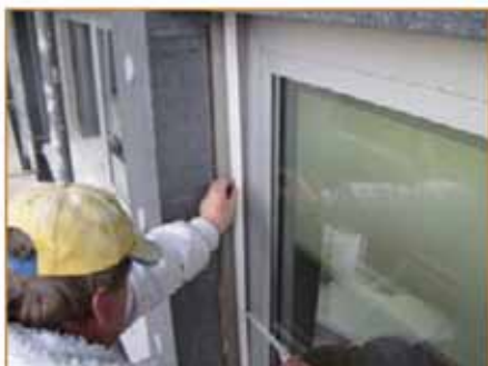
1. Nalepení připojovacího profilu na okenní rám
