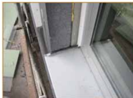
2. Profil připravený pro zasunutí systémové desky
