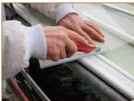
3. Seříznutí systémové desky na požadovanou délku
