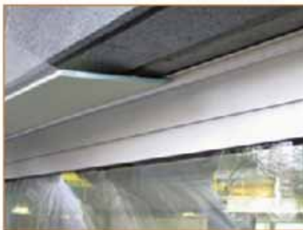
5. Zasunutie systémovej dosky do pripojovacieho profilu
