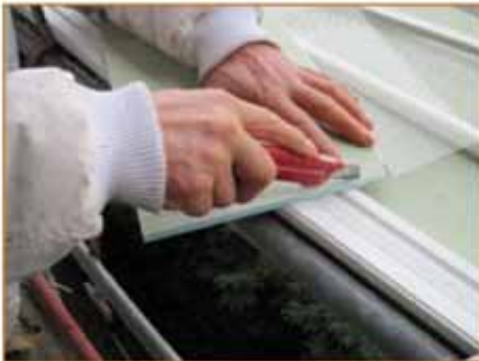
3. Zrezanie systémovej dosky na požadovanú dĺžku
