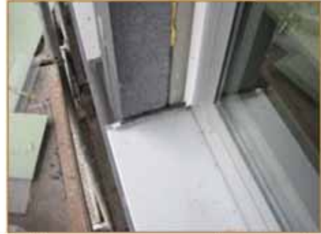
2. Profil pripravený na zasunutie systémovej dosky
