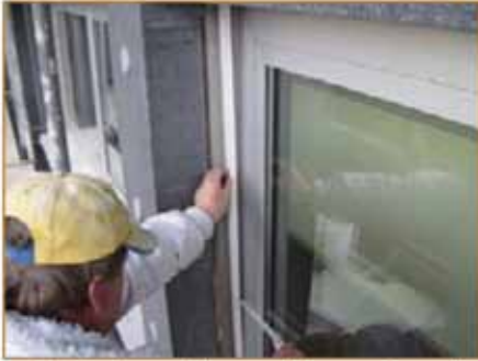
1. Nalepenie pripájacieho profilu na okenný rám
